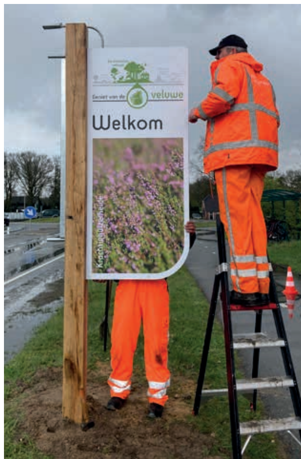
Weer en wind trotseren de medewerkers van het Routebureau bij het plaatsen van borden. Hier monteren zij de komborden in Putten.
